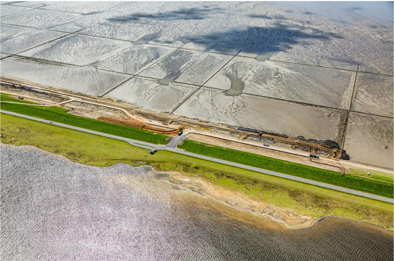
An vielen Stellen entlang der Küste werden die vorhandenen Deiche zu sogenannten Klimadeichen verstärkt. Heute wird ein Überbauen der geschützten Wattflächen weitestgehend vermieden. Für die Verstärkung wird der alte Deich geschlitzt, verbreitert und erhöht und mit neuem Klei wieder abgedeckt. Foto: M. Stock [www.wattenmeerbilder.de](http://www.wattenmeerbilder.de)
